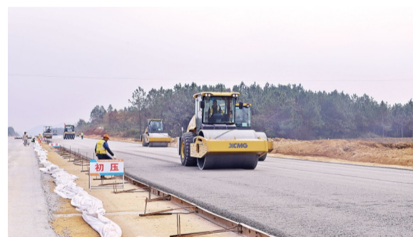
金牛路道路工程项目修建现场。
