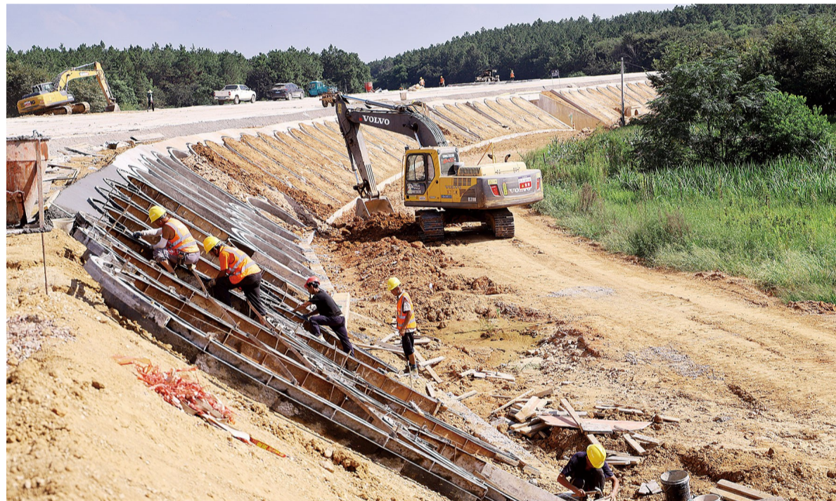
溧宁高速郎溪经开区互通项目修建现场。
