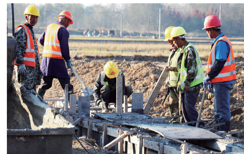
文昌镇施田村高标准农田施工现场。
