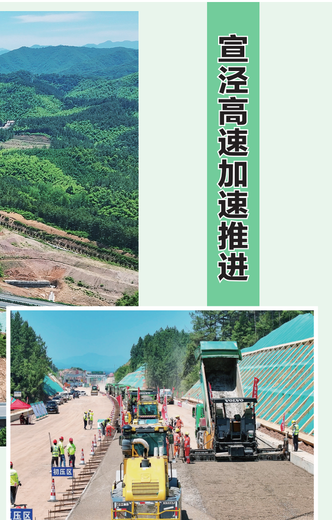
日前,宣泾高速公路二期02标路面水稳基层试验段顺利铺筑,标志着该项目二期路面工程建设正式启动。据了解,宣泾高速公路是我省高速公路布局规划宣城-甘棠-东至高速公路的重要组成部分,主线采用双向四车道高速公路标准。该项目建成后,将成为宣城市中心城区连接泾县的快速通道,对于优化泾县和皖南区域高速公路网布局、支撑皖南国际文化旅游示范区建设,促进长三角一体化高质量发展等具有重大战略意义。何储世豪 摄
