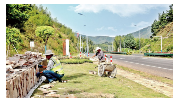
近期,郎溪县交通部门实施“旅游廊道”S203省道道路的绿化提升工程,包括植树补绿、环境整治及微景观建设等,提升路域颜值。图为S203省道姚村段施工场景。 特约记者 王祖清 摄
