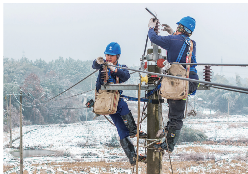
12月19日,宣州区杨柳镇高桥村电力线路抢修现场,电力工人仅用时40分钟便修复受损线路,保障群众稳定用电,温暖越冬。近日,我市迎来大范围雨雪降温天气,国网宣城供电公司全体员工全力以赴赴严寒保供。(本报记者 叶竟文 摄)
