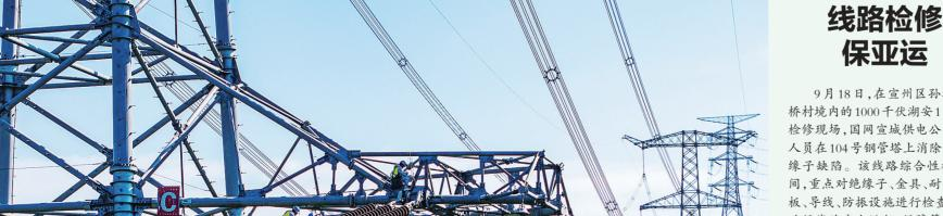
9月18日,在宣州区孙埠镇张 桥村境内的1000千伏湖安1号线路 检修现场,国网宣城供电公司检修 人员在104号钢管塔上消除自爆绝 缘子缺陷。该线路综合性检修期 间,重点对绝缘子、金具、耐张引流 板、导线、防振设施进行检查消缺, 确保线路安全运行,保障第十九届 杭州亚运会用电可靠。韦振 摄
