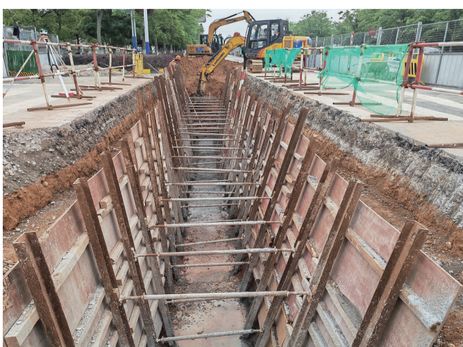
日新路污水管网整治修复现场。
