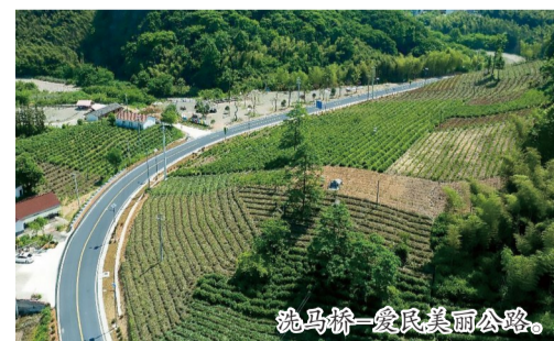
洗马桥-爱民美丽公路。
