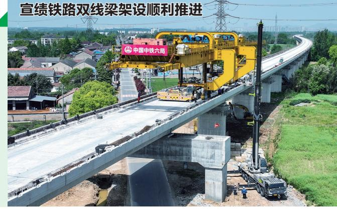
日前,在中铁六局 宣绩铁路一标架梁现 场,一榀长32.6米、重达 790吨的箱梁在向阳大 道特大桥1#墩-0#台平 稳落定,标志着宣绩铁 路站前一标小里程方向 双线梁架设任务全部完 成,架梁进度取得阶段 性胜利,为后续桥面系 及无砟轨道施工的全面 开展奠定了坚实基础。
