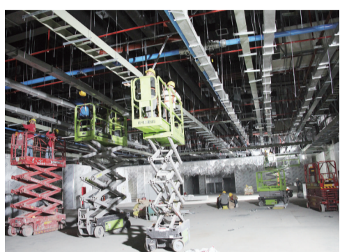
施工人员正在对厂房进行室内装修。
