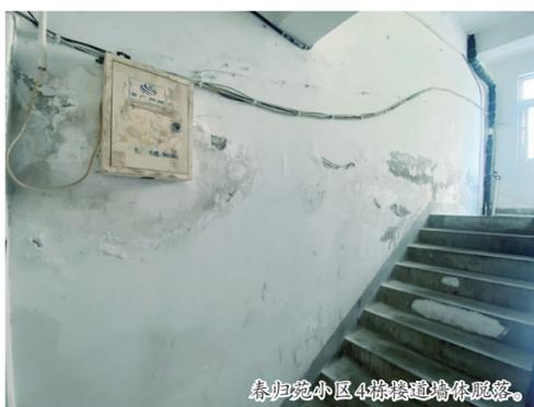
春归苑小区4号楼楼道墙体脱落。
