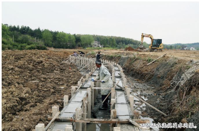
工人正在浇筑引水沟渠。
