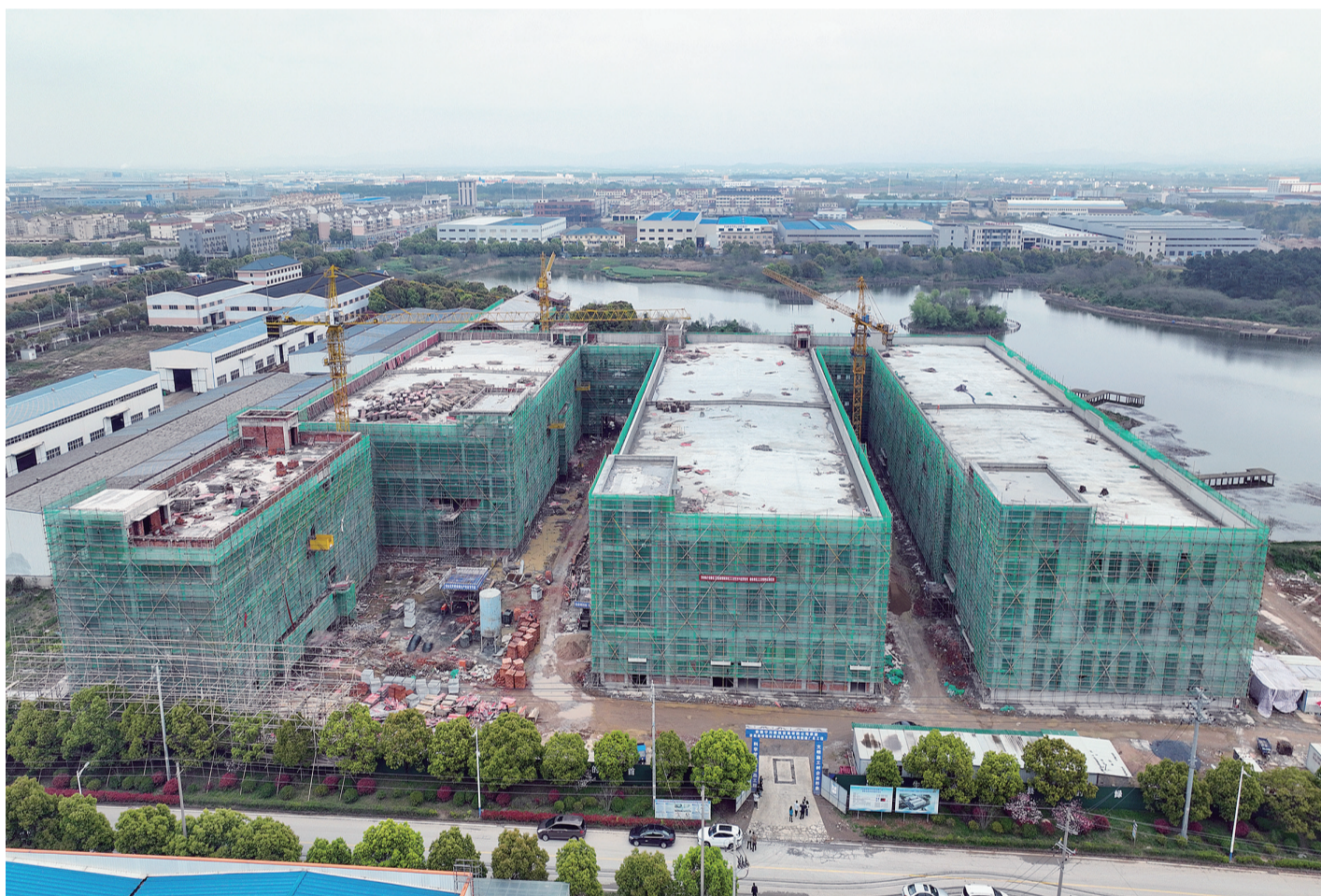
安徽晓球新材料科技有限公司锂电池系列材料配件项目位于郎溪经开区,主要研发、生产小数码3C极耳、新能源汽车及储能大动力极耳、锂电池软包装膜和扣式电池成套包装等产品。项目于去年9月26日开工建设,目前主体工程已竣工,正在进行设备安装,预计今年7月投产。
