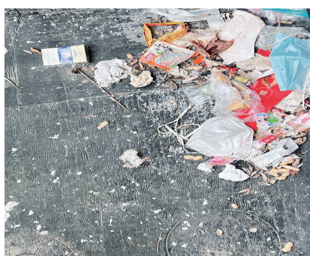
向阳新村A7栋单元楼楼层平台有垃圾。
