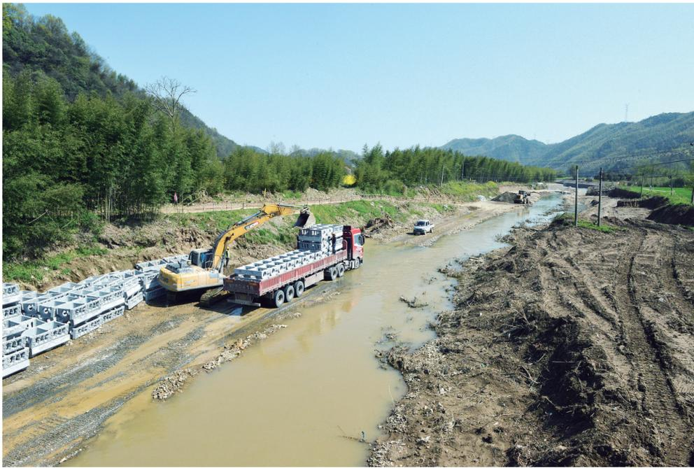
近日,宁国市中津河霞西至经开区河道整治工程(霞西段)建设正酣。据了解,宁国市中津河霞西至经开区河道整治工程是被列入国家防汛抗旱水利提升工程实施方案中小河流治理项目库的项目,项目主要建设内容包括:新建堤防工程、护岸建设工程、河道清淤疏浚和局部拓宽整治工程,工程型式主要采用格宾石笼护岸、箱型砌块护岸,工程建设资金3500余万元。
