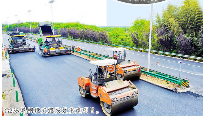
G235界祠段灾毁恢复重建项目。
