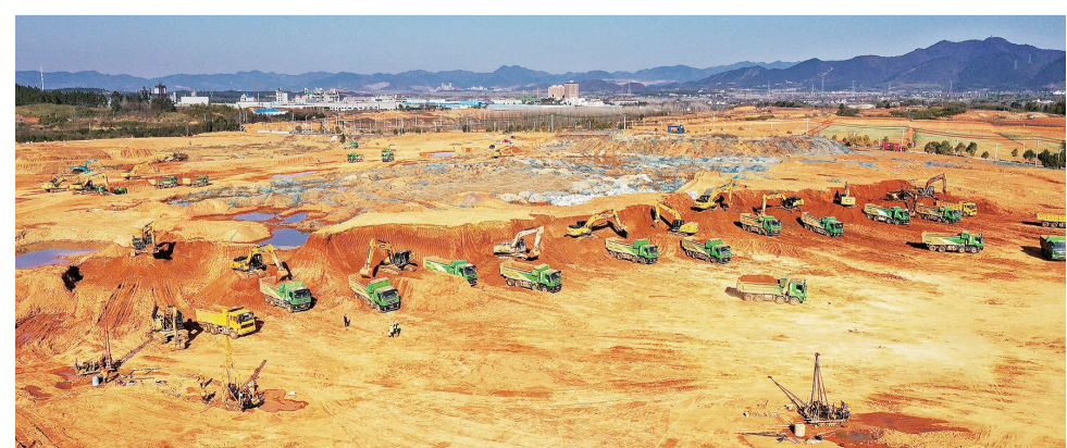
吉利科技动力电池项目建设现场。
