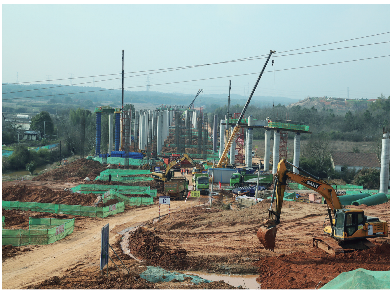
2月21日上午,在宣泾高速公路一期节点性工程——宣城枢纽施工现场,运输车辆往返穿梭,大型吊机轰鸣起吊,挖土机挥臂挖土平坑,一派紧张有序的繁忙景象。
