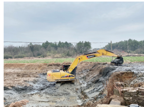
眼下,郎溪县凌笪镇各村正抢抓工期,实施塘坝清淤扩挖,力争在汛期来临之前完成既定建设任务,让群众早受益。去年以来,凌笪镇积极实施塘坝清淤扩挖整治提升三年行动计划,全镇将投入1000余万元,对镇内158座大小塘坝进行整治。截至目前,该镇已完成59座塘坝的扩挖改建,另有22座塘坝正在施工中。特约记者 夏忠羽 摄
