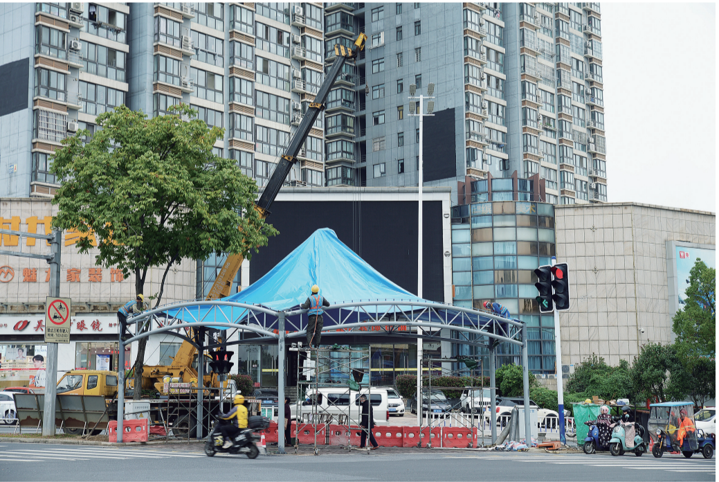
近日，市城管局在市区状元路与梅溪路交叉口、昭亭南路与水阳江大道交叉口两个路口四个方向安装复合式遮阳(雨)棚，为等红灯的非机动车驾驶员和行人遮阳挡雨。图为正在安装的复合式遮阳(雨)棚。本报记者 叶竞文 摄
