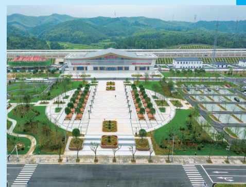
郎溪南站高铁站。
