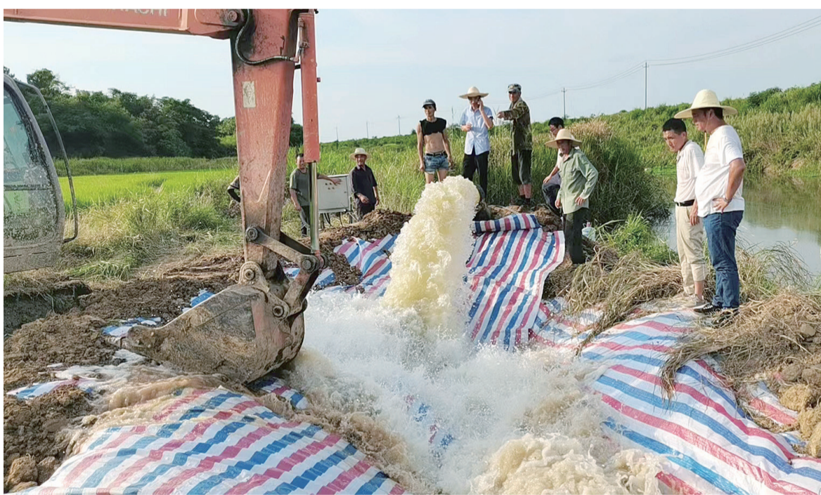
面对持续的旱情,郎溪县毕桥镇迅速行动、综合施策,组织专业部门工作人员深入田间地头,通过采取筑坝拦河、开挖水池、疏通水渠、保障用电等方式,全力以赴抗旱护苗。 特约记者 余克俭 本报记者 叶竞文 摄
