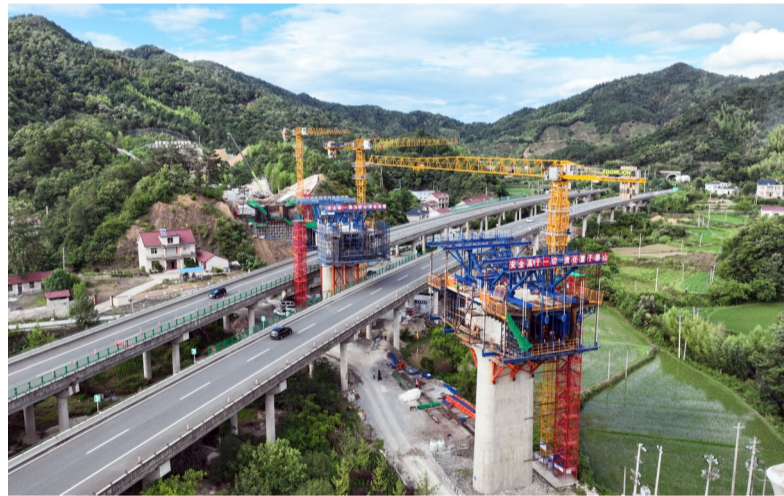
宣绩铁路甲路跨S01溧黄高速特大桥梁施工现场。
