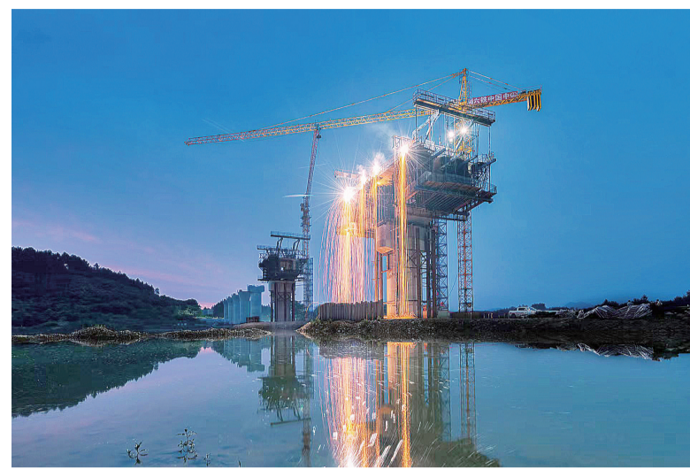
庙上水阳江特大桥梁施工现场。
