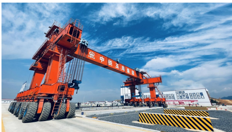
中铁五局宣绩铁路制梁场现场。
