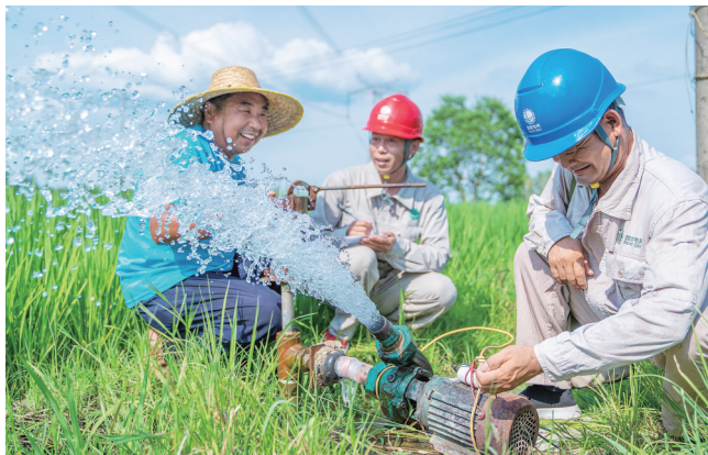
近期持续高温,宣州区向阳社区杨村的农户殷海来正为210亩稻田用水发愁,得知消息后,国网宣城供电公司客户服务人员立马前往田间地头,为客户安装并调试好电抽水泵,告知抽水用电安全注意事项。图为供电服务人员在稻田边帮农户检查电抽水泵运行情况。韦振 摄
