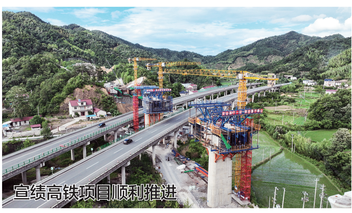
宣绩高铁项目顺利推进 由中铁十四局集团有限公司承担建设的宣绩高速铁路甲路跨S01溧黄高速特大桥,全长1140.3米,共计33跨,在第2-5跨连续梁跨越既有溧黄高速公路,连续梁采用挂篮全封闭施工,最大化的减少对高速公路的影响,桥梁施工期间下部高速公路可以正常通行,图为6月23日连续梁跨越施工现场。 本报记者 戴巍 摄
