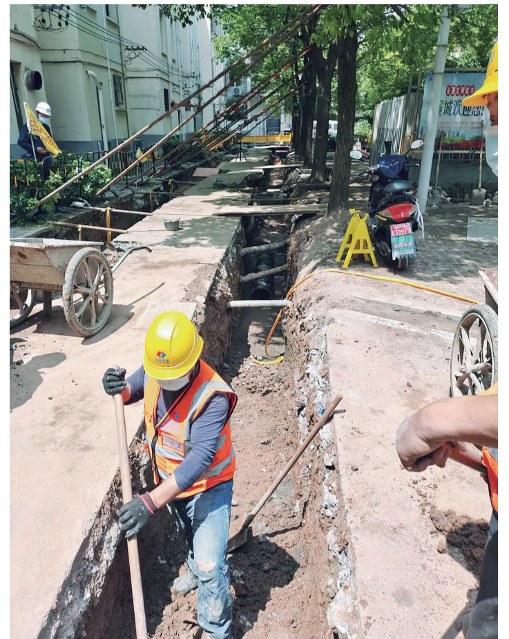
天羽东苑正在进行雨污分流改造。
