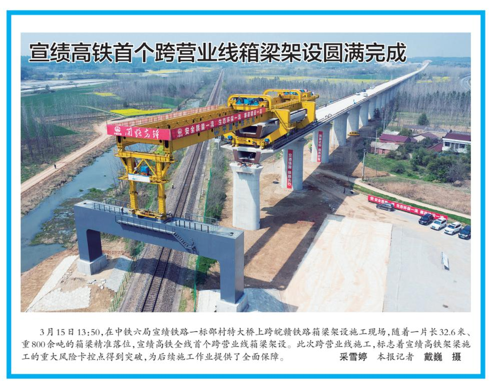
3月15日13:50，在中铁六局宣绩铁路一标邵村特大桥上跨皖赣铁路箱梁架设施工现场，随着一片长32.6米、重800余吨的箱梁精准落位，宣绩高铁全线首个跨营业线箱梁架设。此次跨营业线施工，标志着宣绩高铁架梁施工的重大风险卡控点得到突破，为后续施工作业提供了全面保障。 采雪婷 本报记者 戴巍 摄
