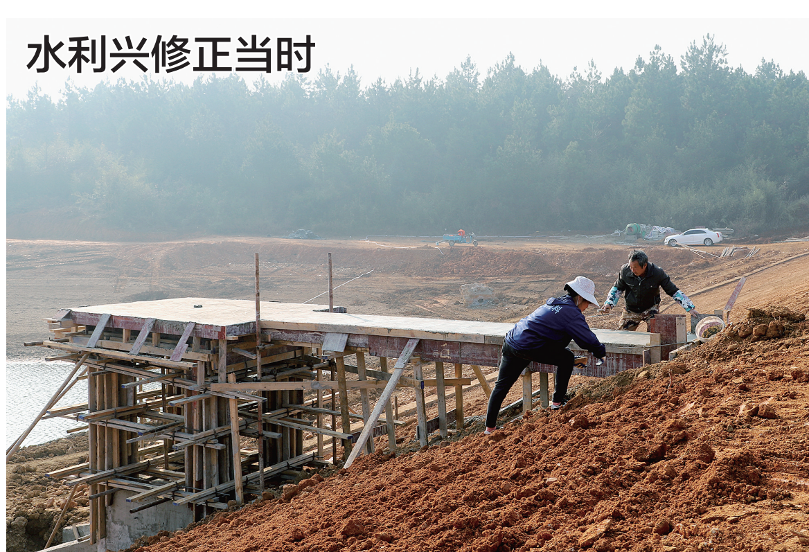
近日,在郎溪县凌笪镇岗南村不旱塘水库施工现场,工人们正在坝迎水坡脚浇筑放水涵洞底板。入冬以来,凌笪镇抢抓枯水期水利兴修好时机,投入85万余元对不旱塘、胜利水库等三处存在安全隐患的重点塘坝进行除险加固、翻建放水涵洞、修复溢洪道等工程,为农业增产增收奠定基础。 特约记者 夏忠羽 摄
