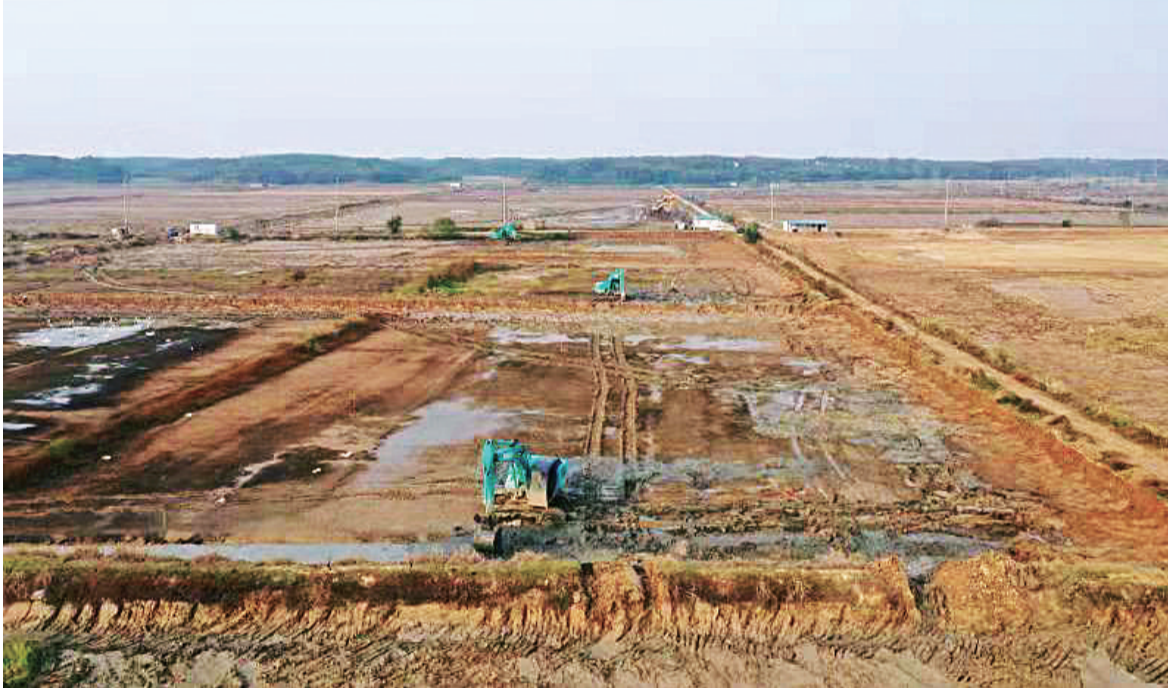
今年以来,郎溪县紧抓农业综合开发高标准农田建设的契机,大力加强农业基础设施建设,为夯实农业生产基础、促进经济社会跨越式发展提供了强有力的支撑。图为飞鲤镇高标准农田施工现场。 特约记者 余克俭 摄
