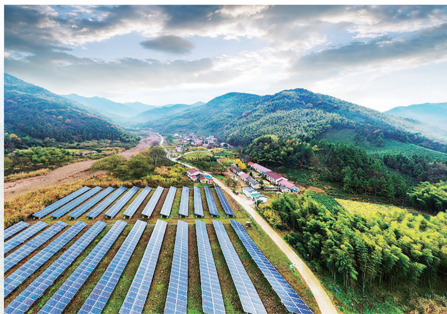
产业扶贫:溪口镇光伏电站
