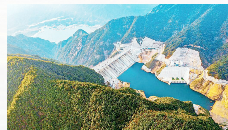
绩溪抽水蓄能电站
