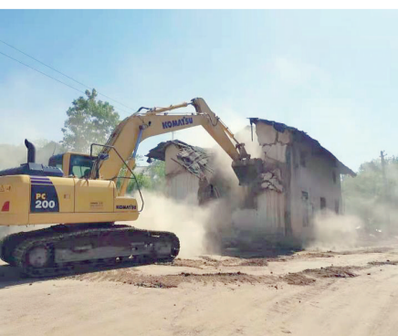
4月29日上午,在挖掘机轰鸣声中,宁安高速房屋征迁工作正式拉开帷幕。宁国至安吉高速安徽段起于宁国市中溪镇狮桥村附近,终于宁国市章村北侧皖浙省界处,全线建设双向四车道高速公路,建设里程11公里,计划总投资15亿元,预计2023年底建成通车。汪静 摄
