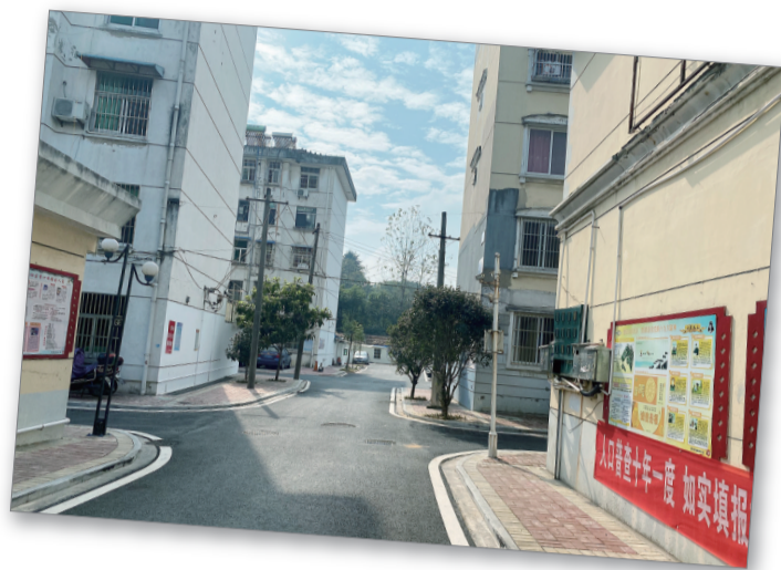
已经完成改造的蚌城花园小区焕然一新。
