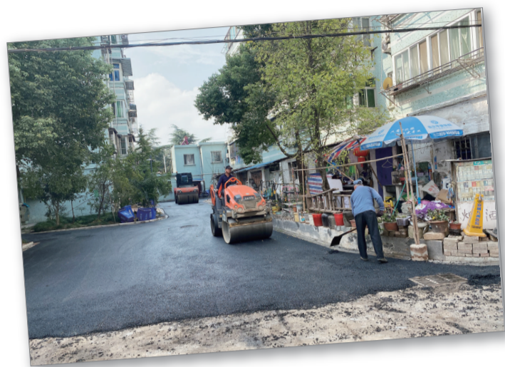
沁园小区道路正在摊铺沥青。
