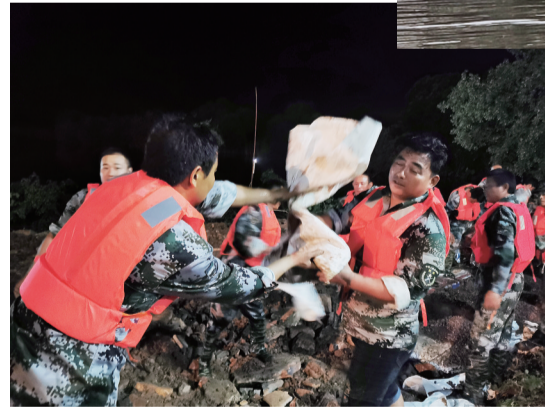
7月14日晚，宣州区朱桥联圩发现多处散浸点。当地立即组织民兵挖好排水沟，填好砂石袋，投入到紧急抢险工作中。
