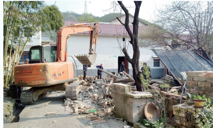
无功能房屋拆除
