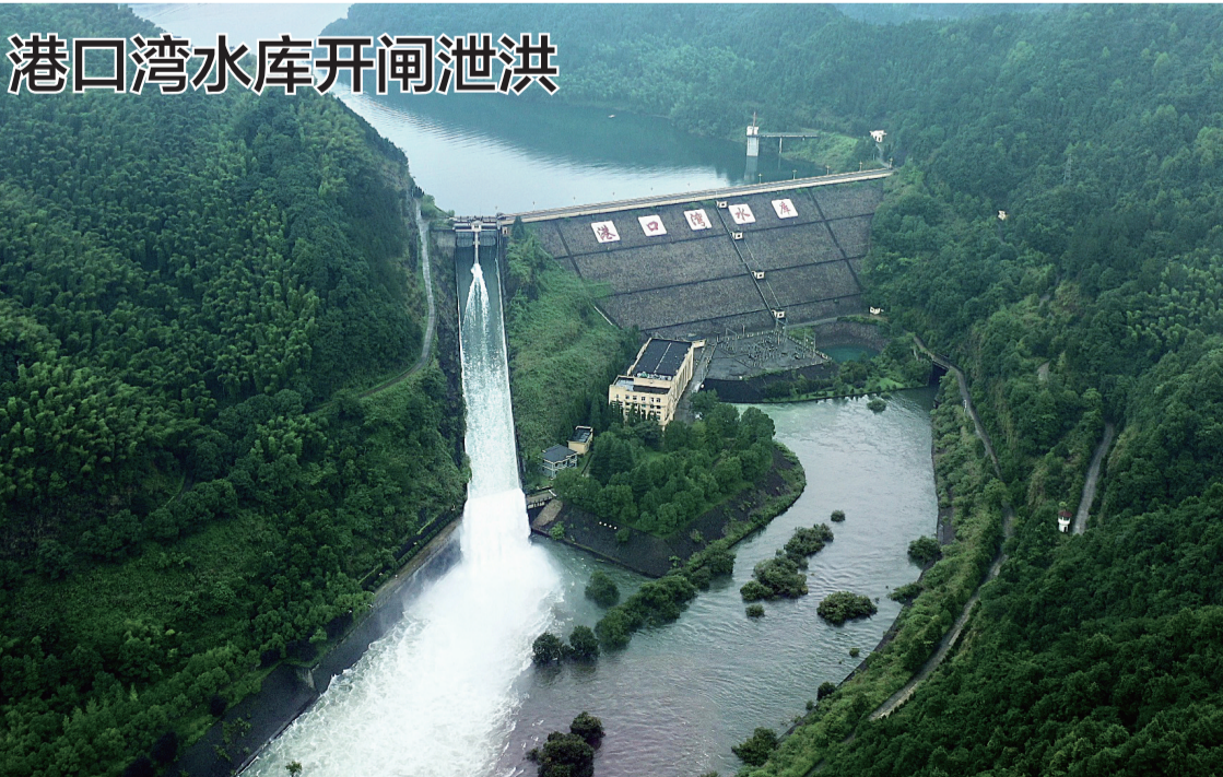
连日的强降雨造成水库、河流水位上涨。7月4日,港口湾水库已经超过汛限水位,达到134.23米,超汛限水位1.23米。港口湾水库管理处接到省水利厅和宣城市水利局指令后,从当天14点起开闸泄洪。泄洪时,下泄流量每秒200立方米。
