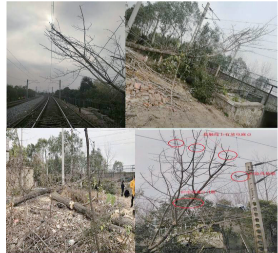
2017年“11.13”京九线倒树引起接触网跳闸
