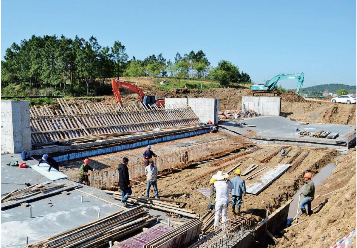
日前，郎溪县凌笪乡清明坝施工现场，施工队正抢抓晴好天气，加紧修建浪水坝和新建桥梁，力争在汛期来临前完成建设任务。 白露茵 特约记者 夏忠羽 摄
