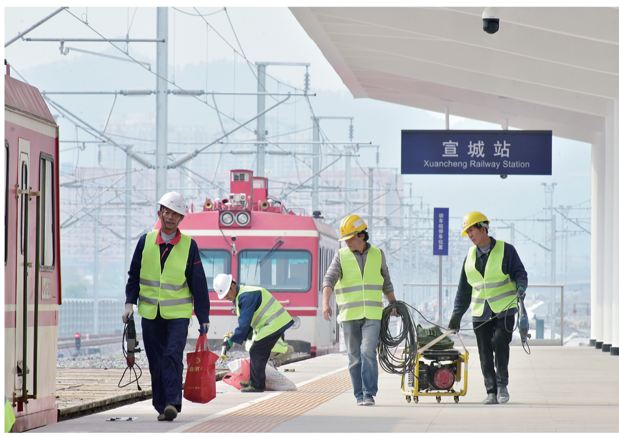
随着4月2日商合杭铁路(南段)开始联调联试,由中铁二十四局集团承建的宣城高铁站建设也进入关键期,截至发稿日,宣城高铁站已经完成总工程的82.74%,站台已经建设完工。 本报记者 戴巍 摄
