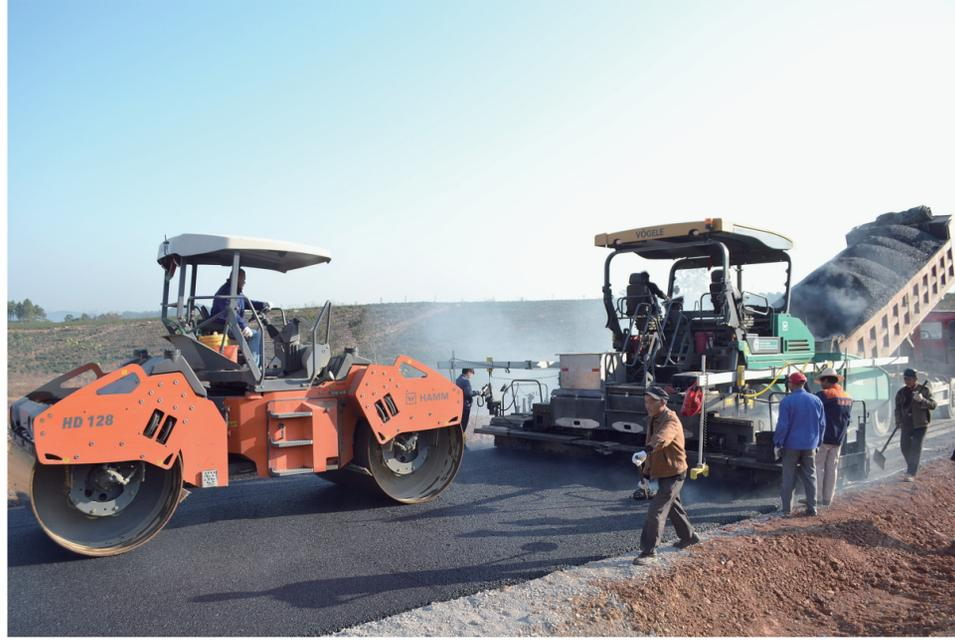
12月10日,郎溪县凌笪乡下吴村环罗市村“四好”农村路施工现场,施工队正在抢抓工期,加紧铺设沥青路面,确保按期完成建设任务。
