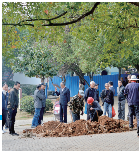
市区大坝塘公园内,一处刚刚开始建造的公厕引起市民的关注。
