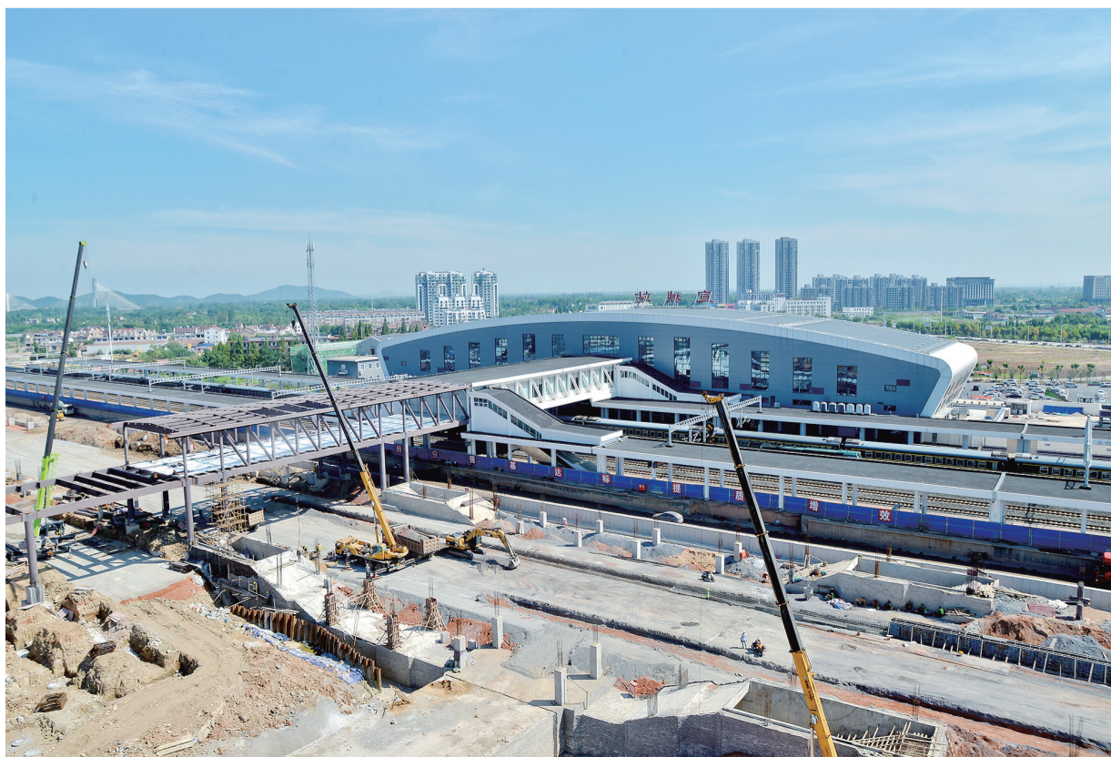
眼下是施工的黄金季节，宣城火车站西站房作为皖赣铁路扩能改造的配套工程，各项施工生产正在抢抓工期，所有工人都奋战在一线。目前正在建设的站前广场站雨棚和天桥即将完成。（本报记者 汪辉 摄）
