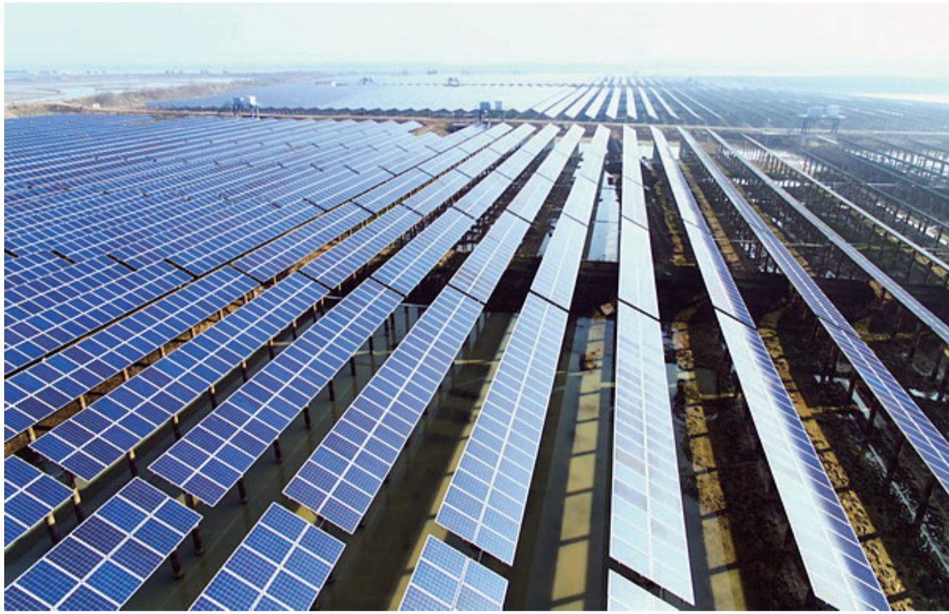
夏天阳光充足,1200亩的浩滩滩涂鱼塘上,一排排整齐的光伏电池组件方阵正加足马力,对外输送着源源不断的清洁电力。这是已竣工投产两年的“渔光互补”光伏发电项目——安徽郎溪盛世40兆瓦渔光互补光伏发电工程。 乌蒙蒙 摄
