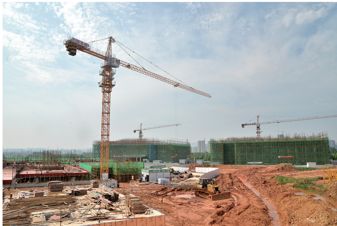
位于宣城市南部文教创意园区的皖南医药卫生学校新校区工程规划总建筑面积约19万平方米,总投资约8.49亿元,规划打造高等医药卫生类学校,计划办学规模约8000人。项目一期办学规模约5000人,一期建筑工程面积约8.5万平方米,投资约4亿元。图为一期工程建设。
